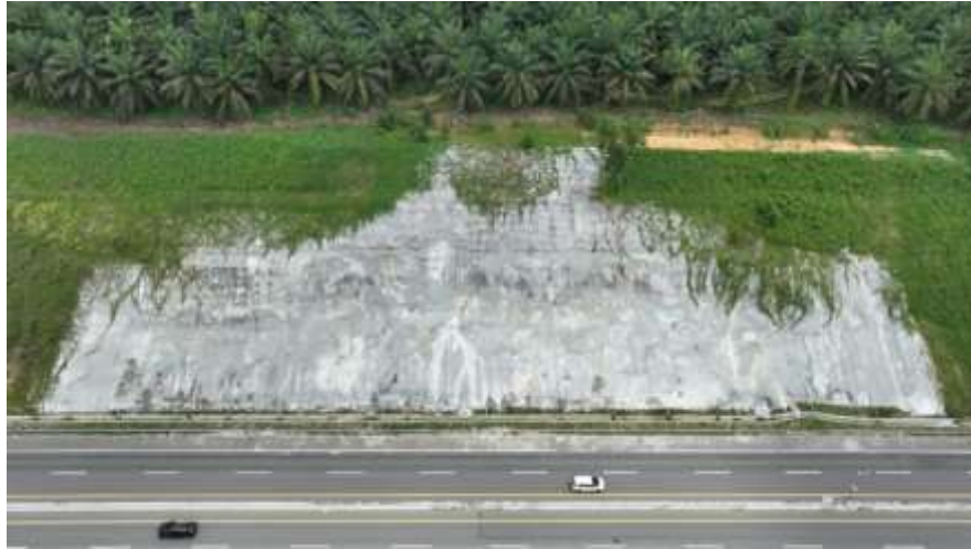
Gambar 4. Kondisi Lereng Pasca Penanganan Akhir
