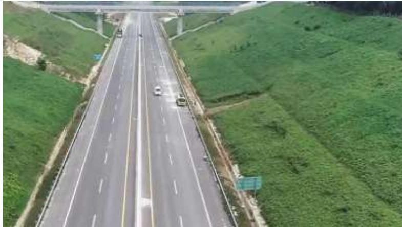
Gambar 2. Kondisi lereng setelah penanaman LCC mulai tumbuh lebat
