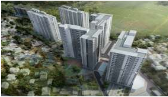
Gambar 3 Kawasan Apartemen Urbantown Karawang
