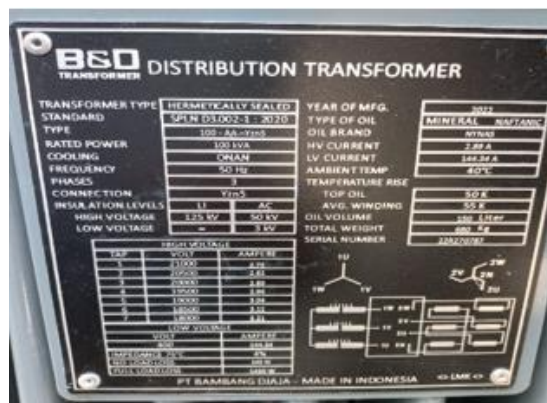
Gambar 4. Namplet Trafo
