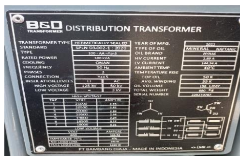
Gambar 2. Namplet Trafo
